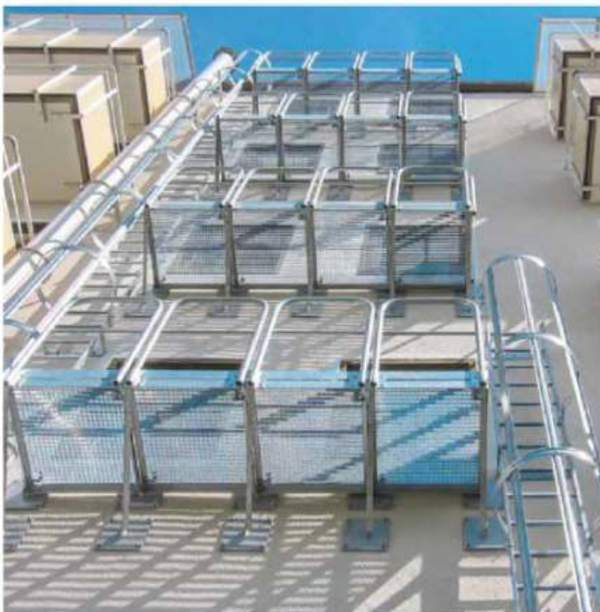
Эвакуационная лестница жилого здания
