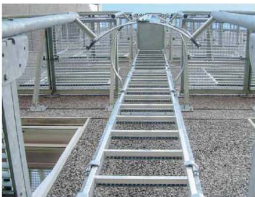
Эвакуационная лестница жилого здания
