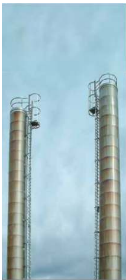
Лестницы со страховочным ограждением на трубах
